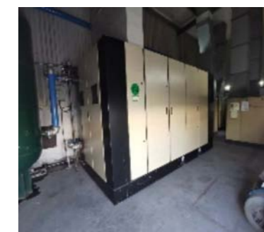
绍兴基地采用节能型空压机
